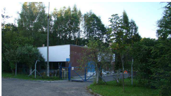
Teren 16K – przepompownia ścieków RS Żwaków
