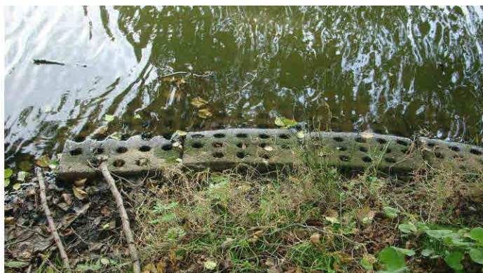
W jednym ze stawów linia brzegowa ukształtowana została z wykorzystaniem elementów betonowych,
