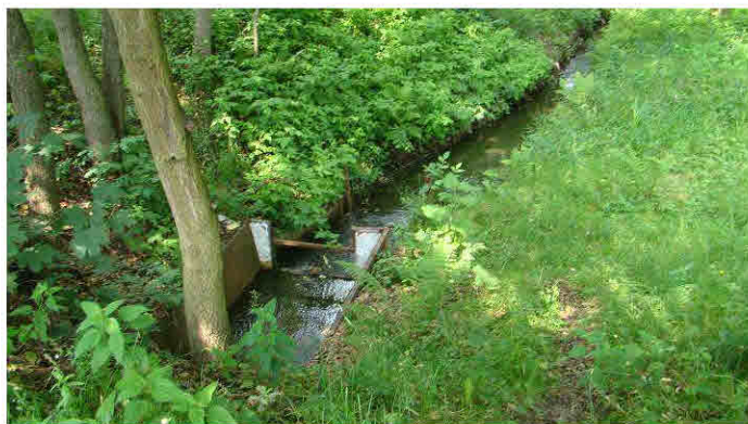
Rów odprowadzający nadmiar wód ze stawu do potoku Tyskiego (dalej płynący przez ogródki działkowe)
