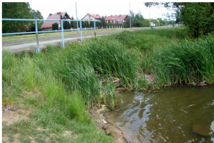
Widok na przepust pod drogą – powiązanie pomiędzy zbiornikami Suble
