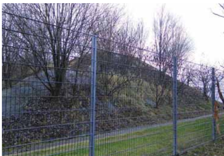
Widok na nasyp ziemny znajdujący się w granicach opracowania.
