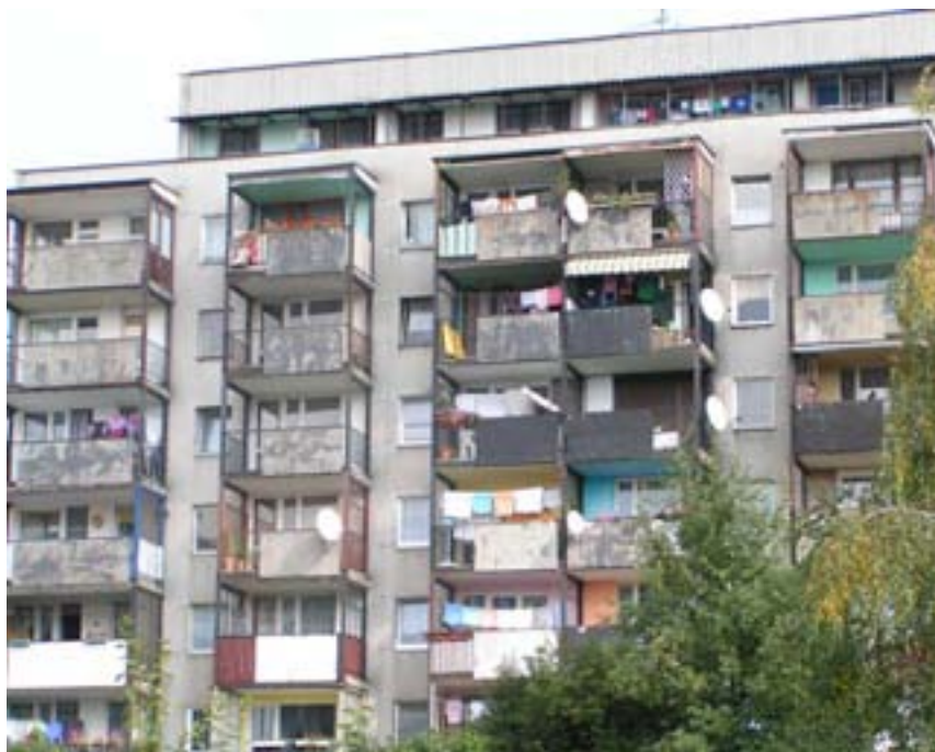
Fot. 20. Blokowiska na osiedlu U
