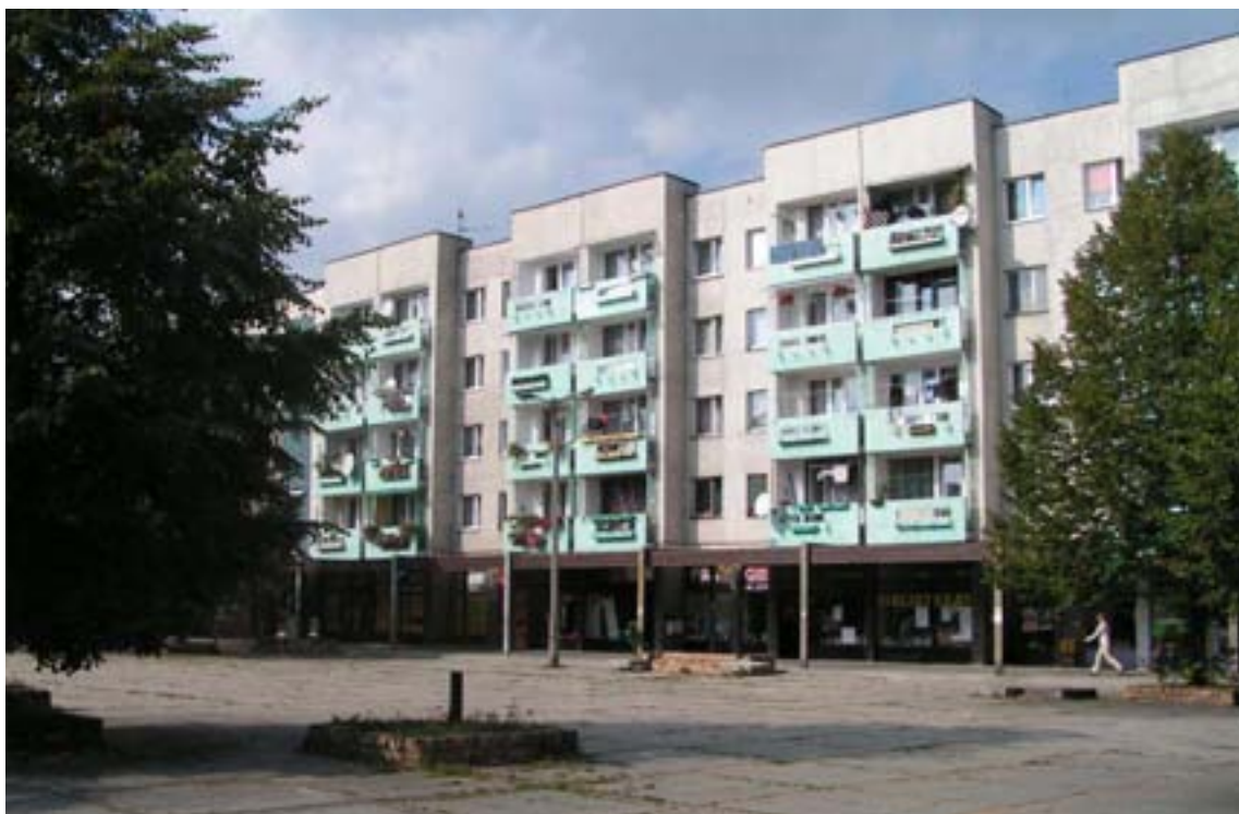
Fot. 22. Plac Korfantego – osiedle K, wymagający modernizacji
