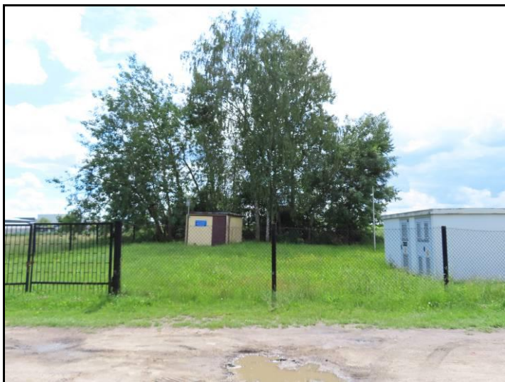
Fot. 5 Teren ujęcia i strefa ochrony bezpośredniej w północno-zachodniej części obszaru
