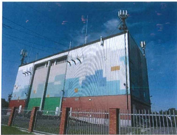
Zal. nr 1: Widok ogólny instalacji radiokomunikacyjnej.
