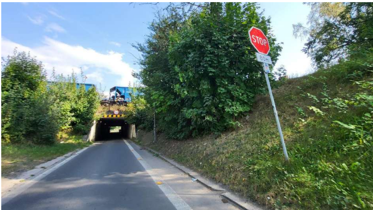
Zdjęcie 1. 10. Wiadukt pod linią kolejową w ciągu ul. Browarowej
