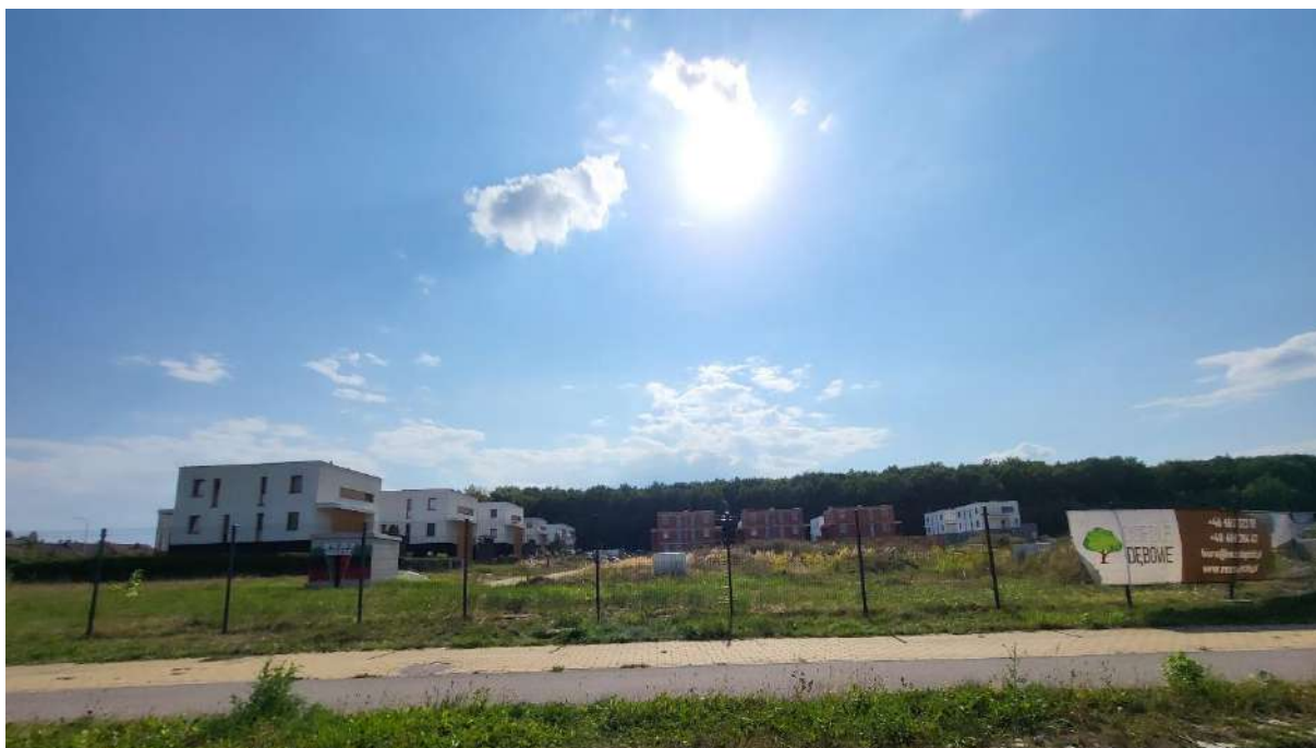
Zdjęcie 1. 7. Widok na realizowane osiedle mieszkaniowe w rejonie ul. Obywatelskiej
