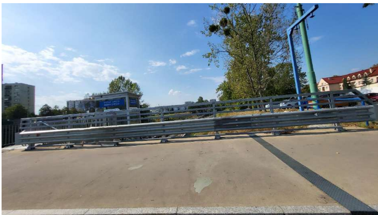
Zdjęcie 1. 32. Wiadukt nad torami kolejowymi w ciągu ul. Generała Grot-Roweckiego
