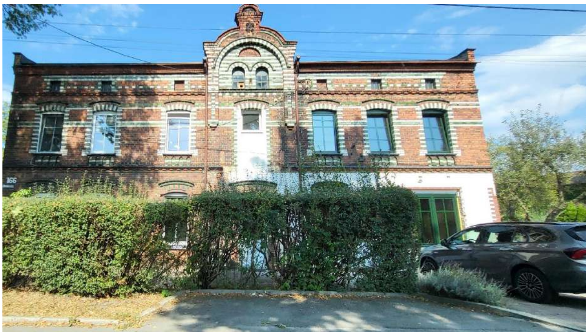
Zdjęcie 1. 11. Kamienica mieszkalna przy ul. Damrota
