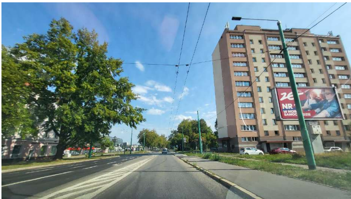
Zdjęcie 1. 27. Układ drogowy – ul. Edukacji oraz zabudowa mieszkaniowa wielorodzinna i sieć trakcyjna trolejbusowa
