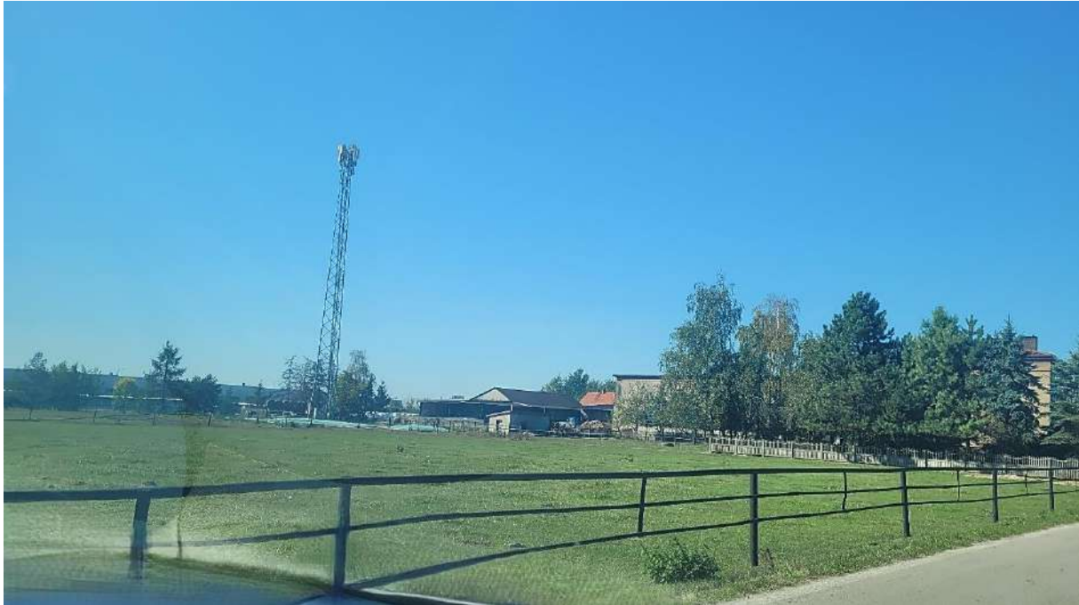
Zdjęcie 1. 53. Maszt stacji bazowej telefonii komórkowej zlokalizowany na terenach otwartych
