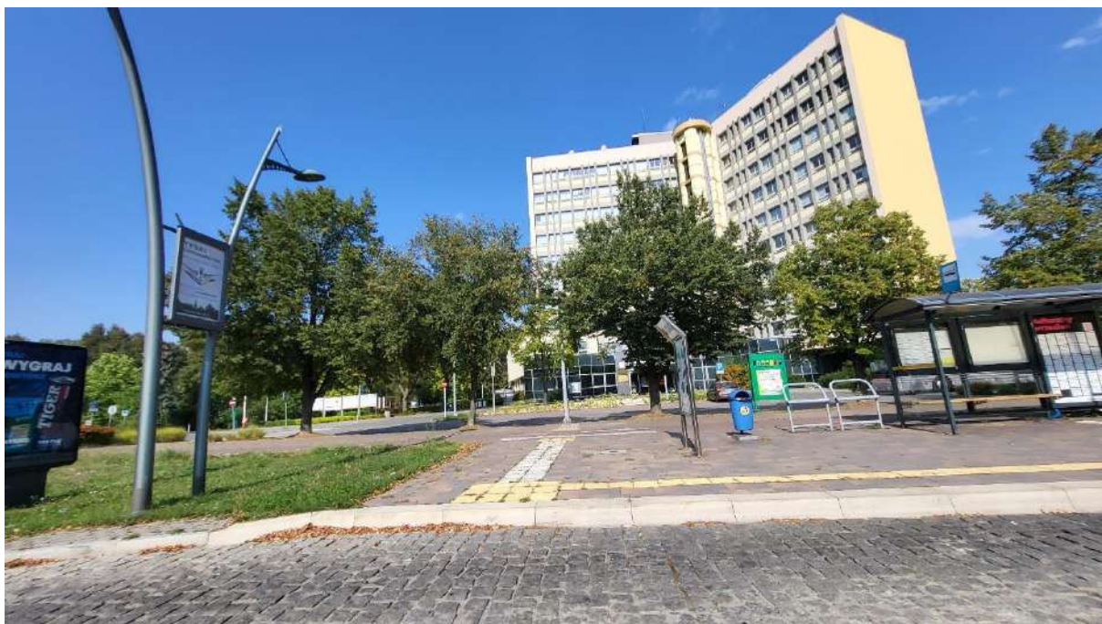
Zdjęcie 1. 31. Budynek Urzędu Miasta Tychy przy Al. Niepodległości
