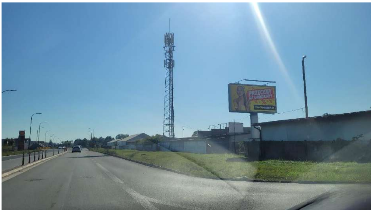
Zdjęcie 1. 51. Układ drogowy – ul. Oświęcimska oraz budynki magazynów i hal, a także maszt stacji bazowej telefonii komórkowej
