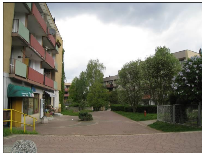
Fot. 15 Zieloniec w rejonie ul. A. Zelwerowicza
