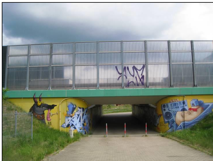
Fot. 5 Przejazd dla rowerów na północ od ul. J. Targiela
