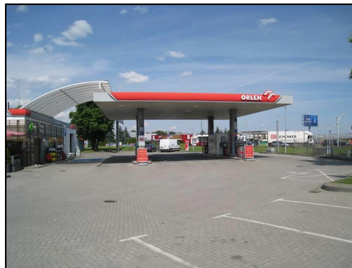
Fot. 3 Stacja paliw w części południowo-wschodniej
