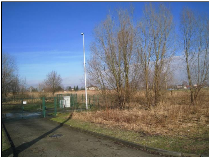
Fot. 9 Południowo-wschodnia część terenu, rejon przepompowni ścieków
