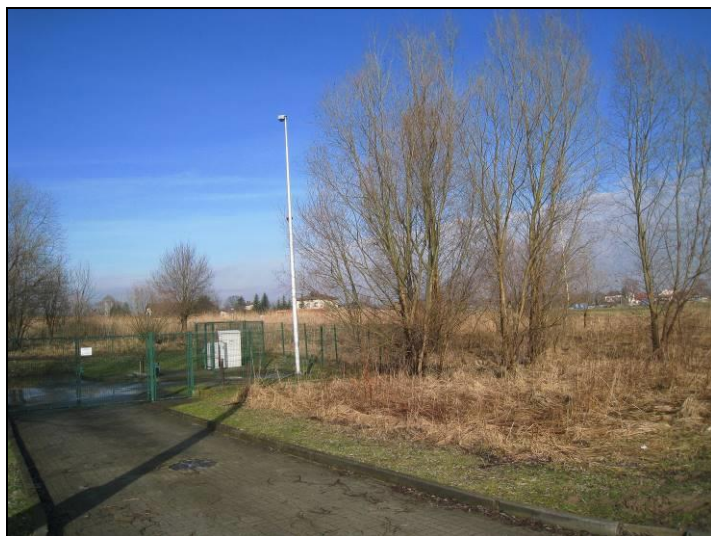
Fot. 9 Południowo-wschodnia część terenu, rejon przepompowni ścieków
