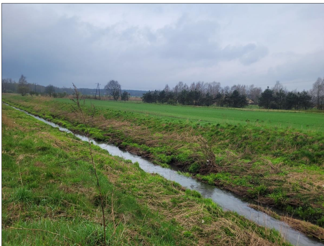
FOTOGRAFIA 10. POTOK TYSKI – WIDOK W KIERUNKU POŁUDNIOWYM (MARZEC-KWIECIEŃ 2023 R.)
