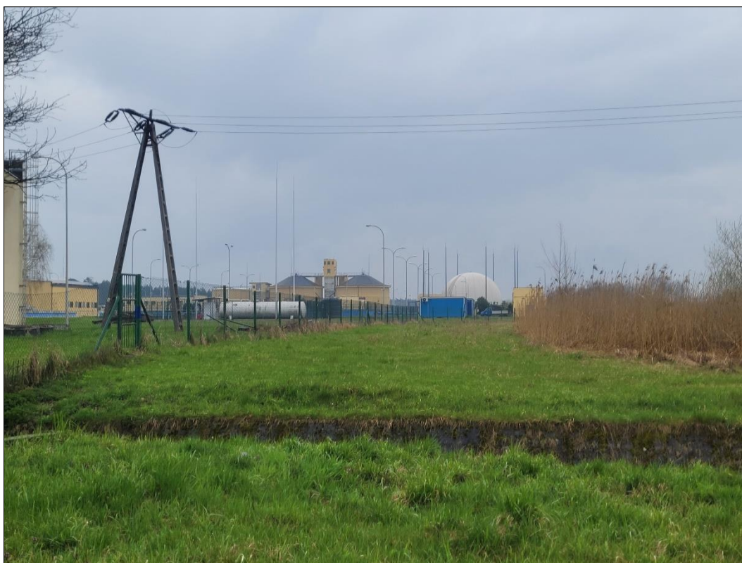
FOTOGRAFIA 8. GRANICA PÓŁNOCNA PRZEDMIOTOWEGO TERENU – SĄSIEDZTWO Z OCZYSZCZALNIĄ ŚCIEKÓW (MARZEC-KWIECIEŃ 2023 R.)
