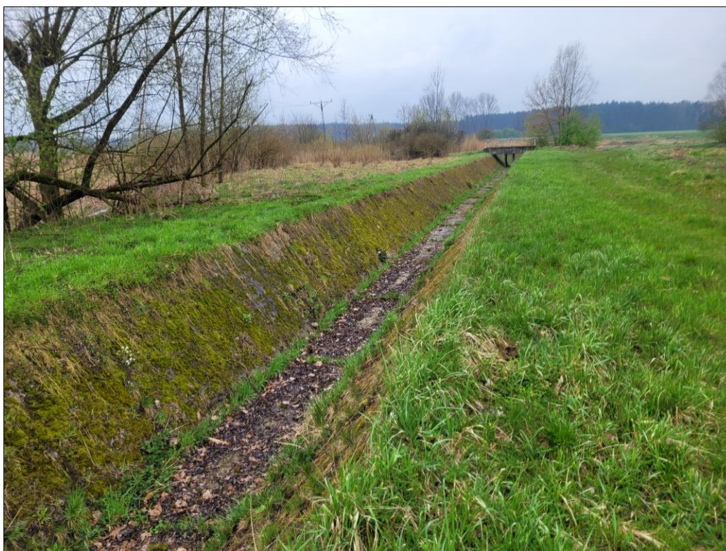
FOTOGRAFIA 2. JEDEN Z KANAŁÓW ŚCIEKOWYCH – SUCHY – WYBETONOWANE KORYTO
