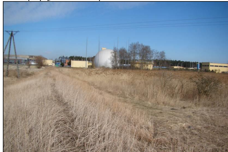
Fot. 4 Jak powyżej, widok w kierunku oczyszczalni ścieków
