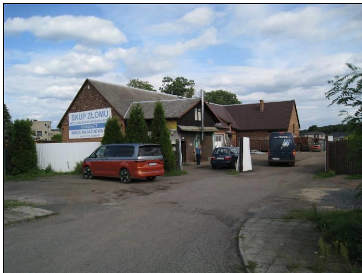
Fot. 1 Analizowany teren od strony zachodniej
