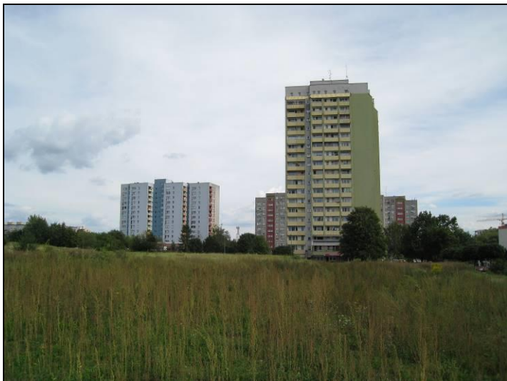
Fot. 13 Widok w kierunku wschodnim
