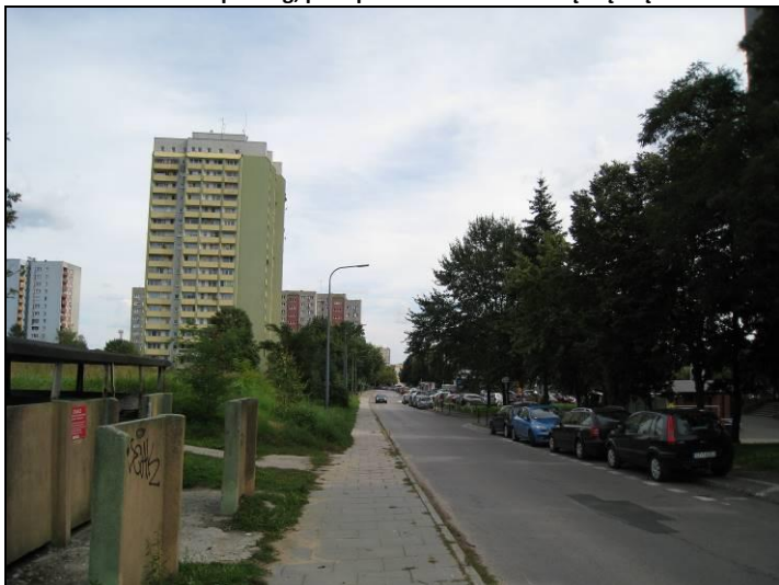
Fot. 10 Ul. Z. Nałkowskiej, południowa granica terenu, widok w kierunku wschodnim
