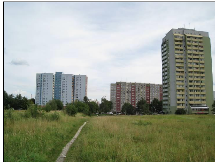
Fot. 15 Widok w kierunku wschodnim
