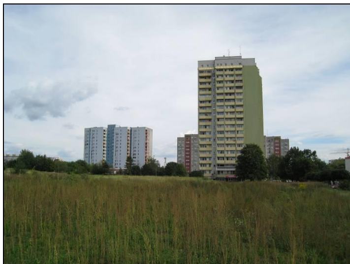
Fot. 13 Widok w kierunku wschodnim
