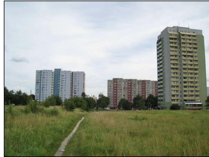
Fot. 15 Widok w kierunku wschodnim
