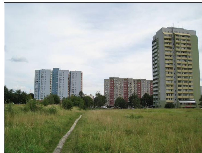
Fot. 15 Widok w kierunku wschodnim
