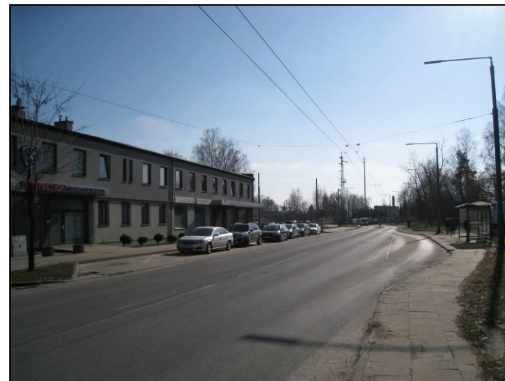
Fot. 11 Zabudowa usługowa w części zachodniej terenu
