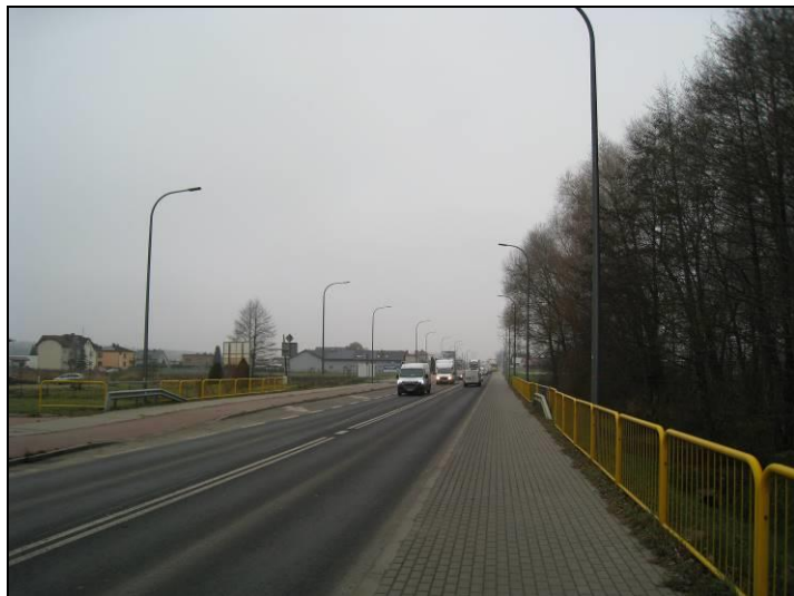
Fot. 9 Ul. Oświęcimska, widok w kierunku zachodnim
