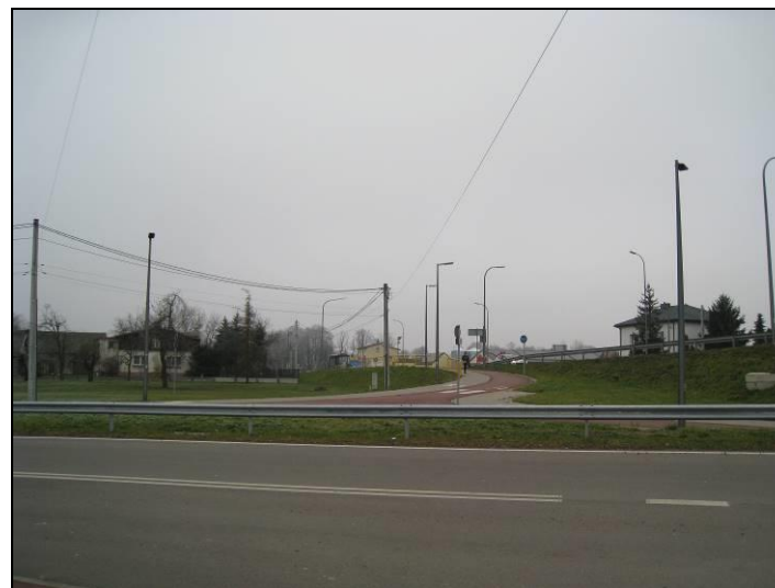
Fot. 7 Północno-wschodnia część terenu
