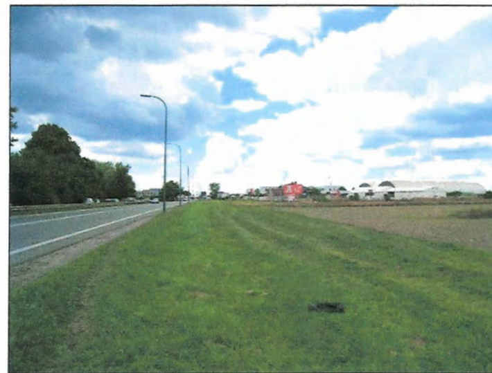
Fot. 7 Ul. Oświęcimska w południowo-zachodniej części terenu
