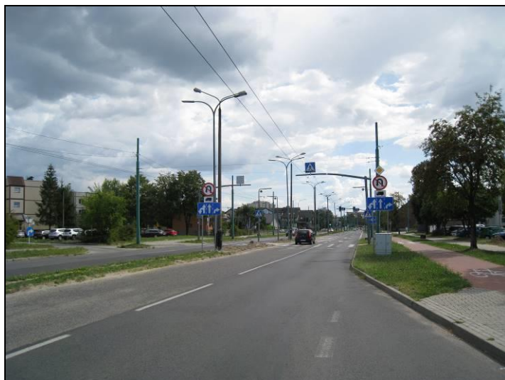
Fot. 5 Ul. Harcerska, widok w kierunku zachodnim
