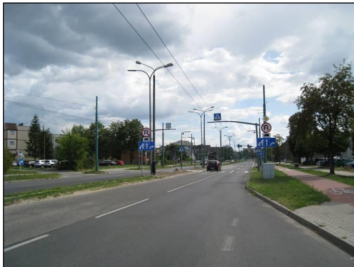
Fot. 5 Ul. Harcerska, widok w kierunku zachodnim
