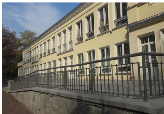
Fot. Termomodernizacja przy ul. Andersa
