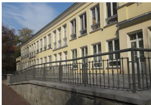
Fot. Termomodernizacja przy ul. Andersa
