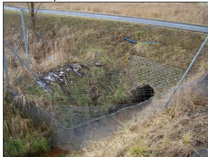
Fot. 8 Wyływ cieką zasilającego staw Grabowiec spod nowo powstałej ulicy
