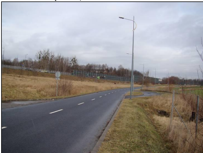
Fot. 10 Nowo powstała droga w zachodniej części obszaru
