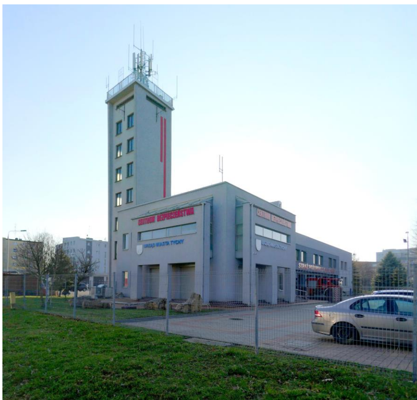
Fotografia 16 Centrum Bezpieczeństwa i Straż Pożarna w Tychach (fot. M.Rolka)
