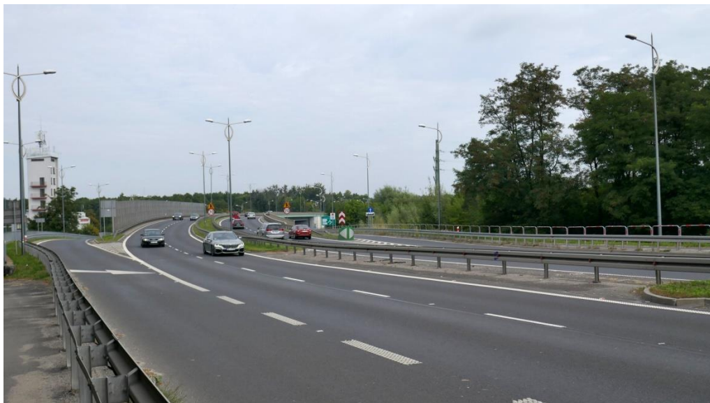
Fotografia 5 Przebudowany węzeł drogowy na drodze krajowej nr 1 (fot. M. Rolka)
