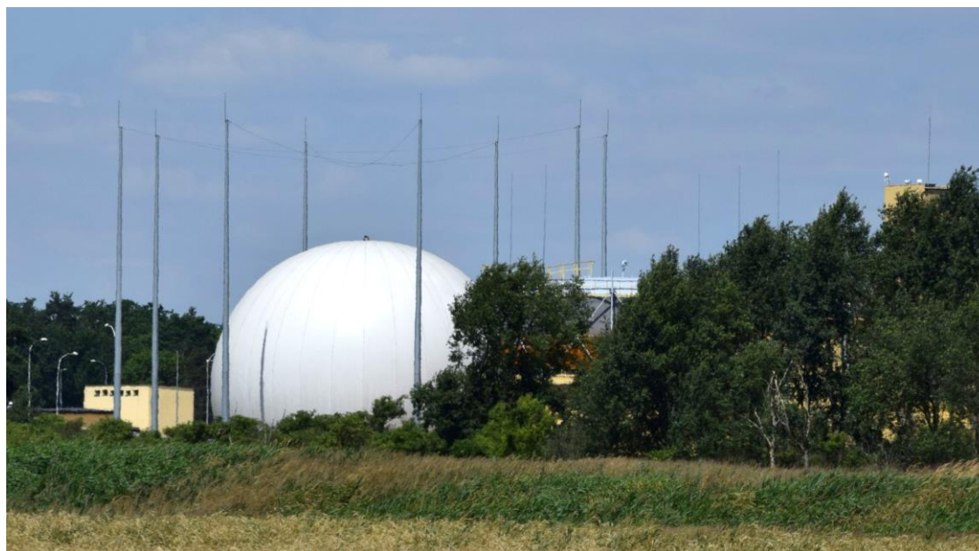
Fotografia 11 Zbiornik na biogaz przy oczyszczalni ścieków (fot. M.Rolka)
