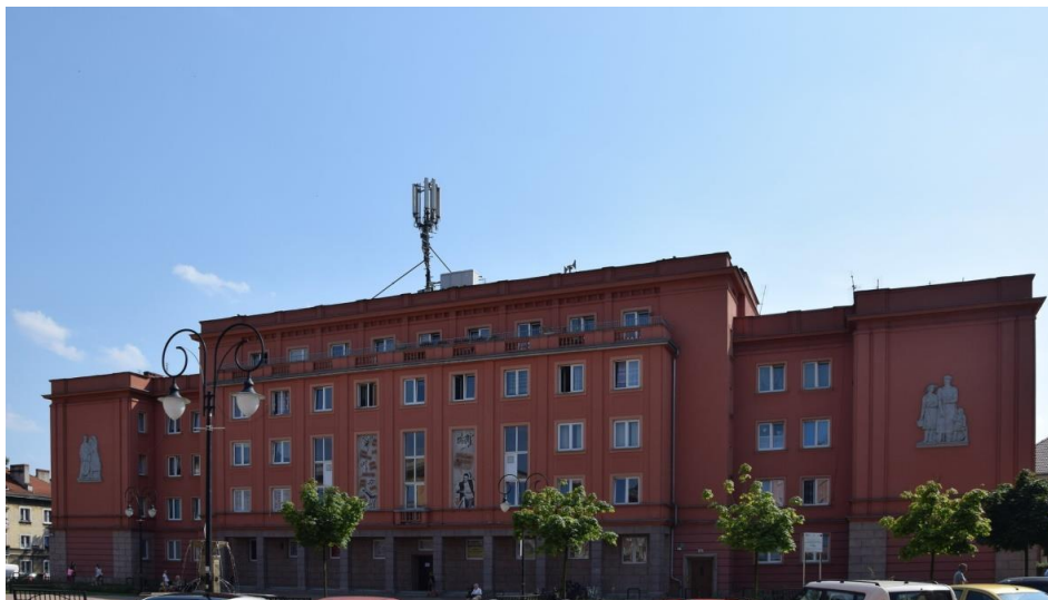
Fotografia 8 Maszt telefonii komórkowej na budynku przy placu Sw. Anny (Osiedle A) (fot. M.Rolka)
