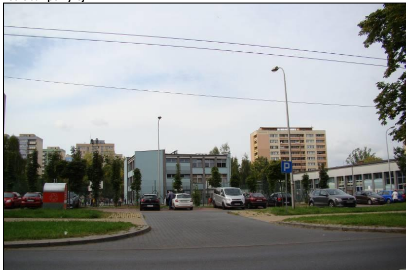
Fot. 6 Budynek szkoły na zachód od ul. Kard. S. Wyszyńskiego
