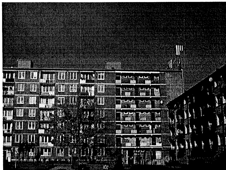
Zał. nr 1: Widok ogólny instalacji radiokomunikacyjnej.
