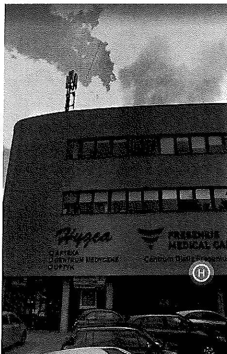
Zal. nr 1: Widok ogólny badanego obiektu.
