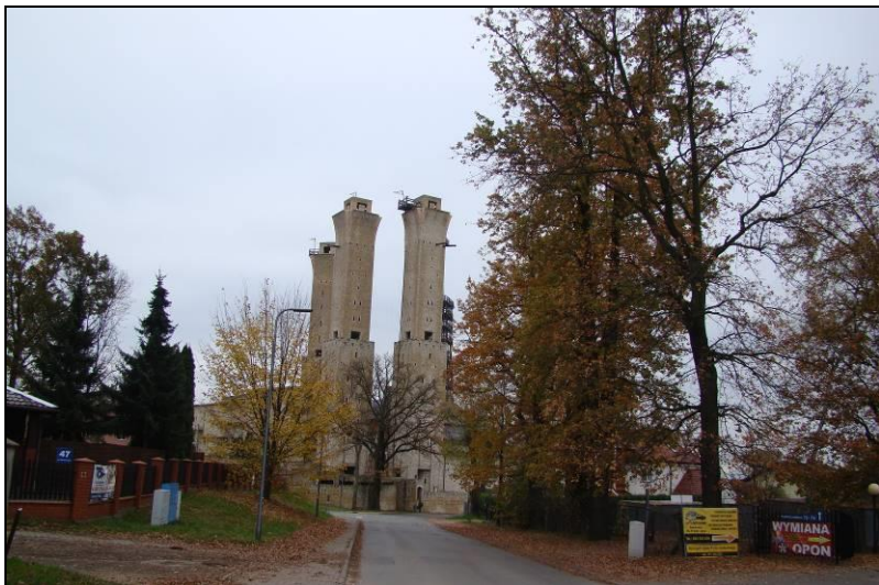
Fot. 5 Widok na budowany kościół pw. Św. Franciszka i Św. Klary
