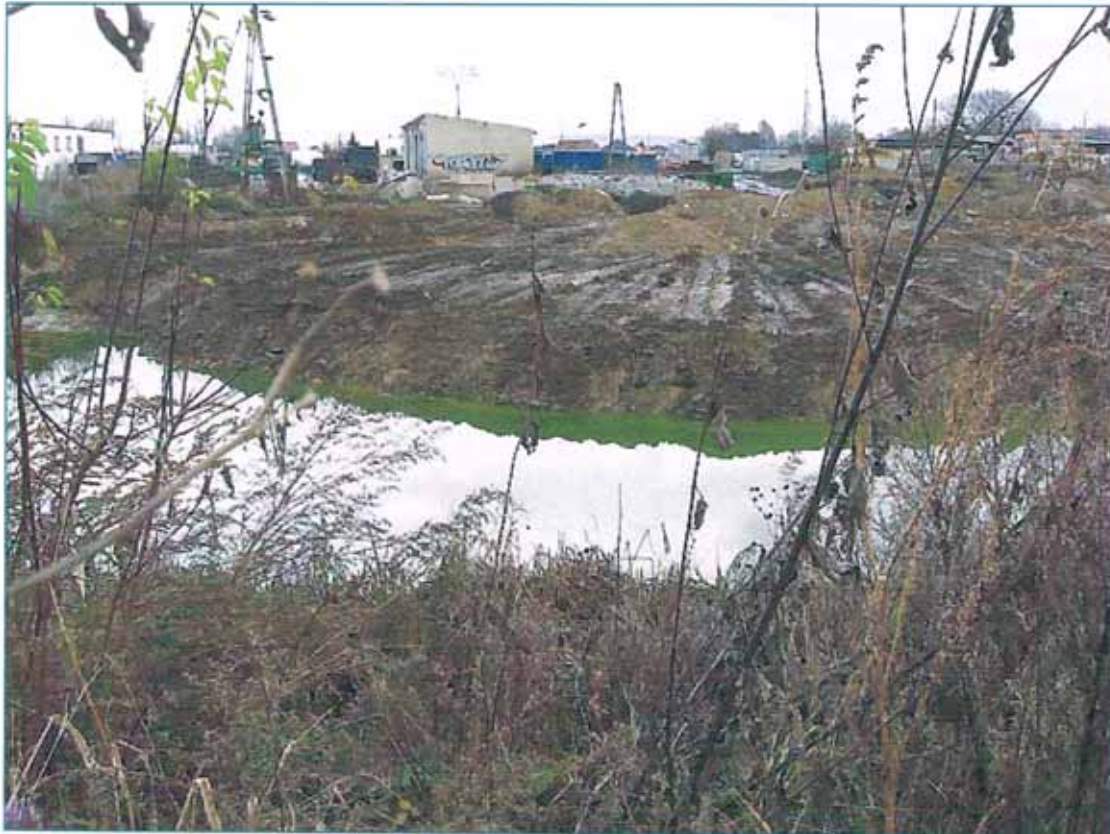
Fot. 2. Zasypany mniejszy zbiornik wodny. Stan w dniu 18 listopada 2009
