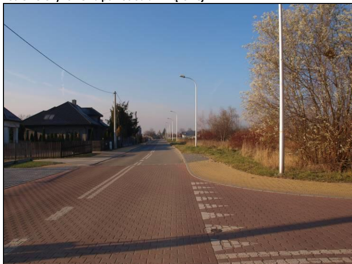
Fot. 6 Ul. Wiązowa, widok od strony wschodniej
