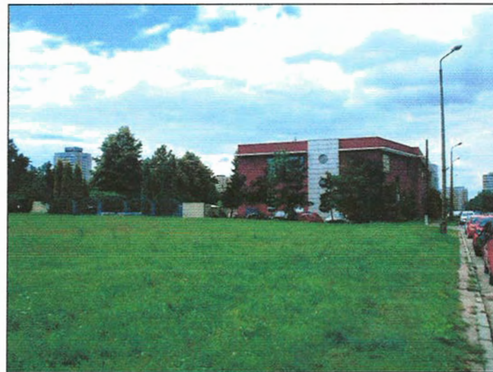
Fot. 7 Budynek poczty, widok od strony ul. Dąbrowskiego
