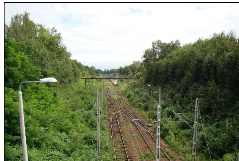
Fot. 15 Linia kolejowa przecinająca obszaru nr 2
