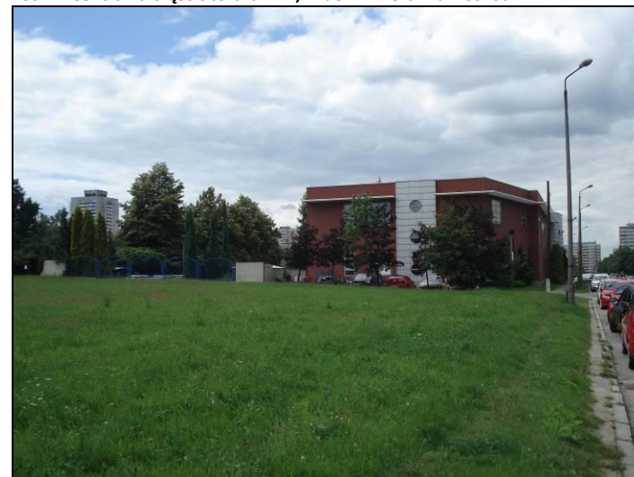
Fot. 12 Obszar nr 2, budynek poczty, widok od strony ul. Dąbrowskiego
