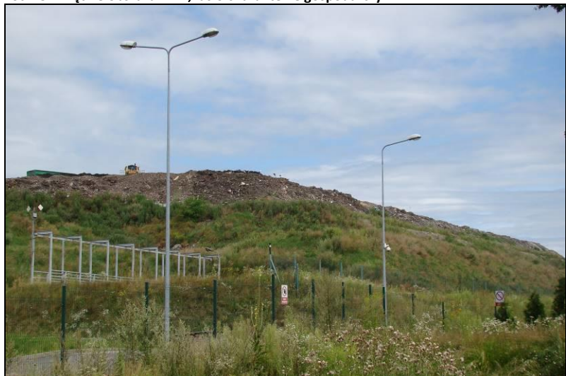
Fot. 26 Składowisko odpadów na północny wschód od obszaru nr 4
