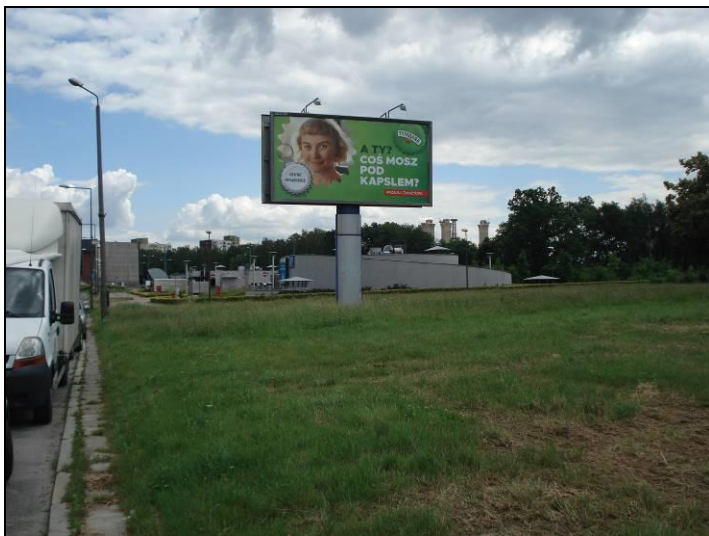
Fot. 6 Obszar nr 2, widok w kierunku wschodnim na parking
