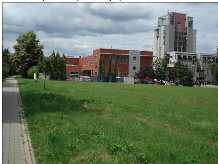
Fot. 10 Budynek poczty w części centralnej obszaru nr 2
