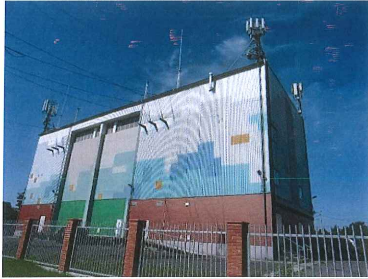
Zal. nr 1: Widok ogólny instalacji radiokomunikacyjnej.
