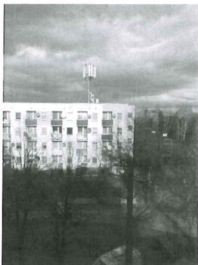
Widok obiektu wraz z zainstalowanym zespołem antenowym
