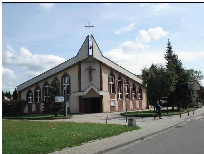
Fot. 1 Południowa część obszaru, widok na kościół pw. Świętej Rodziny
