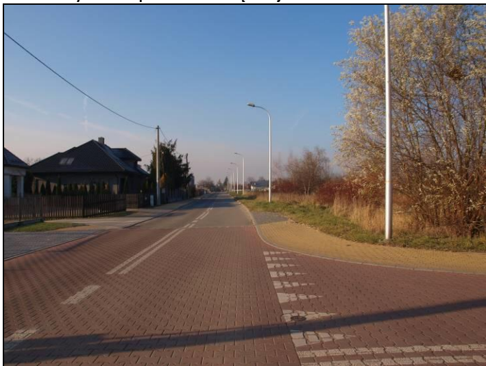
Fot. 6 Ul. Wiązowa, widok od strony wschodniej
