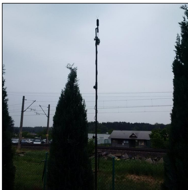
Rys. 6 Widok linii kolejowej nr 139 na wysokości ul. Nizinnej.
