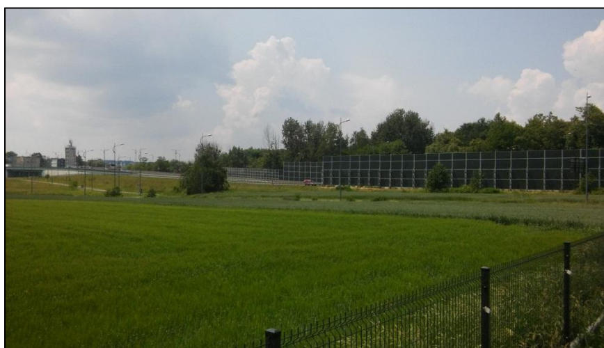
Rys. 3 Widok drogi krajowej nr 1 w rejonie węzła z Al. Niepodległości.
