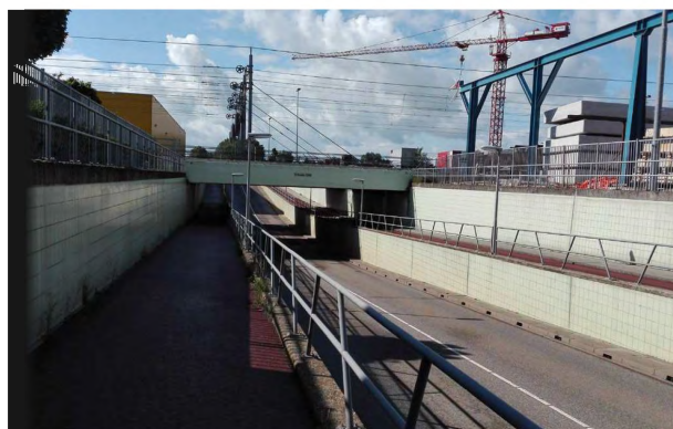
Zdjęcie 13 Niveleta drogi dla rowerów prowadzona powyżej niwelety jezdni. Amsterdamski, Holandia
