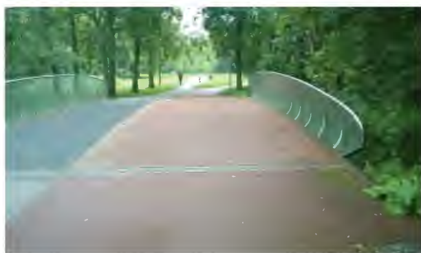
Zdjęcie 63 Kładka z barierą łukową. Amsterdam, Holandia
