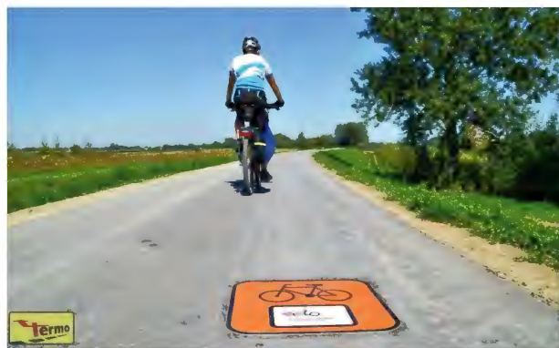
Zdjęcie 71 Oznakowanie poziome R-4 w ciągu VeloDunajec. Matopolska, Polska, termoznak.pl
