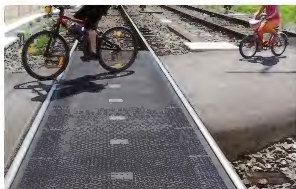
Zdjęcie 41 Bezrowkowy przejazd rowerowy przez linię kolejową. Niemcy
