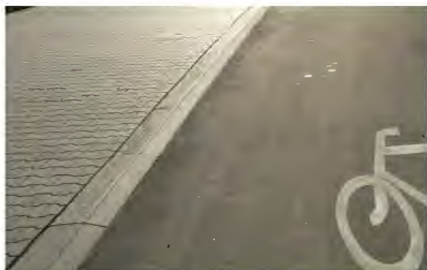
Zdjęcie 17 Obniżenie drogi dla rowerów względem chodnika przy pomocy krawężnika utożonego „na płask”. Wrocław, Polska
