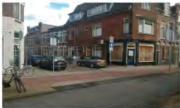
Zdjęcie 36 Droga dla rowerów z zachowaną ciągłością niwelety i nawierzchni przez drogę podporządkowaną. Amsterdam, Holandia
