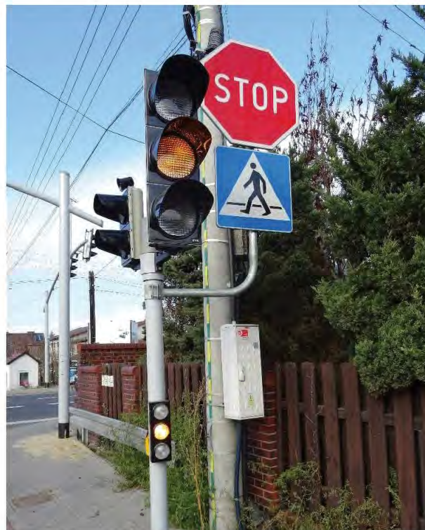
Zdjęcie 51 Sygnalizator pomocniczy o średnicy 100 mm. Polska, Gliwice
