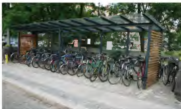
Zdjęcie 77 Zadaszony parking przy dworcu kolejowym. Opole, Polska
