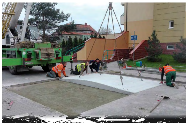
Zdjęcie 31 Montaż progu sinusoidalnego. Wrocław, Polska
