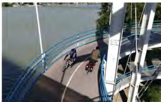
Zdjęcie 62 Pochylnia łącząca drogę dla rowerów z terenem skracającą w lewo w dół. Wiedeń, Austria
