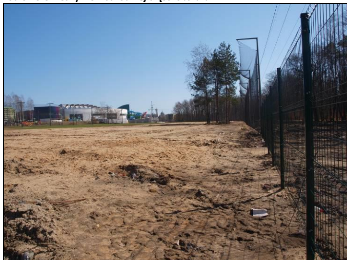
Fot. 6 Pole golfowe w centralnej części obszaru, w trakcie realizacji
