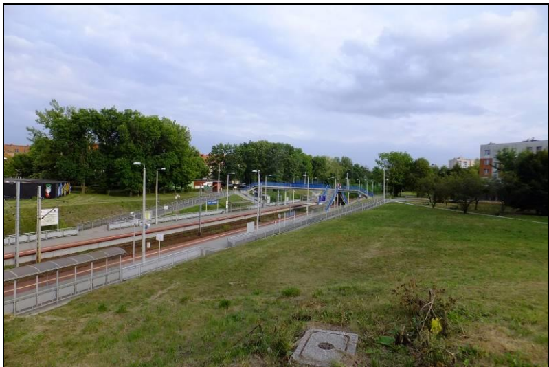
Fot. 5 Linia kolejowa, tuż poza północno-wschodnią granicą opracowania
