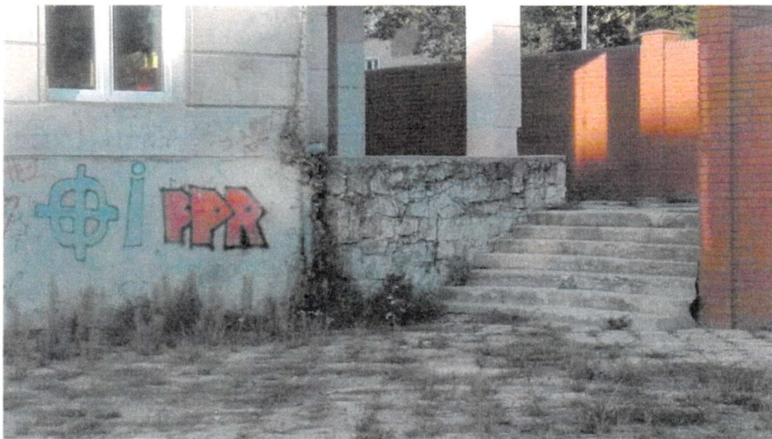
Zdj.3 Nawierzchnia przy boisku szkolnym 2017-08-30
