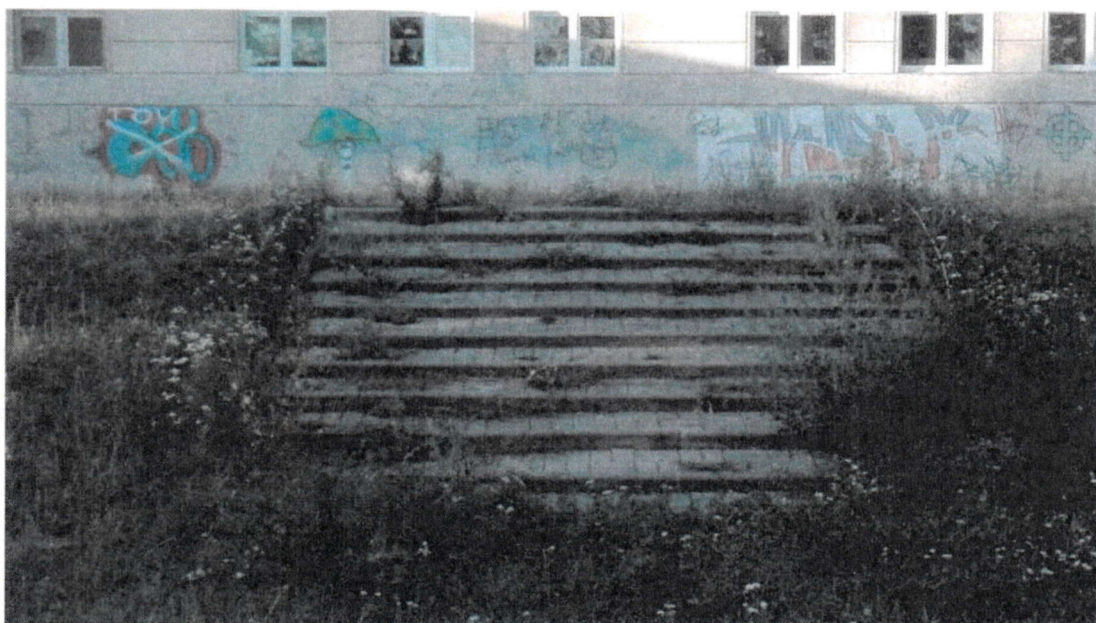
Zdj.4 Nawierzchnia na terenie SP Nr 3. 2017-08-30
