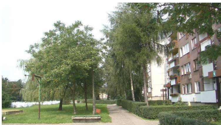
Wschodnia granica przedmiotowego terenu – zabudowa blokowa osiedla H” przy ulicy Honoraty
