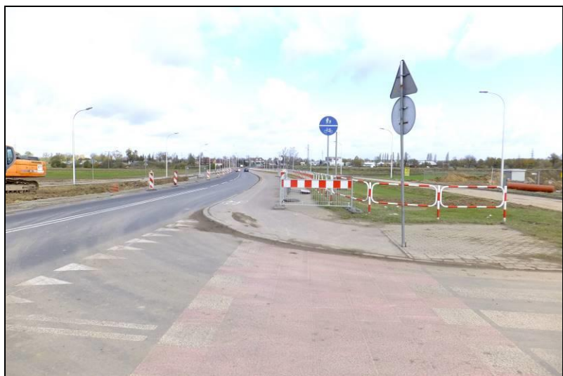
Fot. 2 Widok w kierunku północnym, ul. Serdeczna
