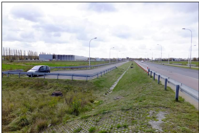
Fot. 1 Widok w kierunku południowym, ul. Serdeczna
