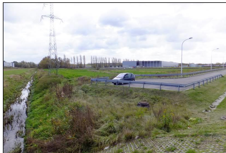
Fot. 4 Widok w kierunku południowo-wschodnim, na pierwszym planie widoczny Potok Tyski, na drugim planie nowo wybudowane obiekty magazynowe
