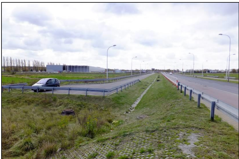
Fot. 1 Widok w kierunku południowym, ul. Serdeczna
