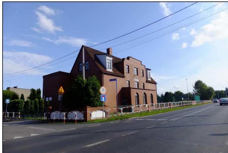
Fot. 15 Budynek zabytkowej szkoły przy ul. Katowickiej
