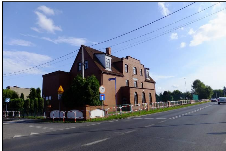
Fot. 15 Budynek zabytkowej szkoły przy ul. Katowickiej
