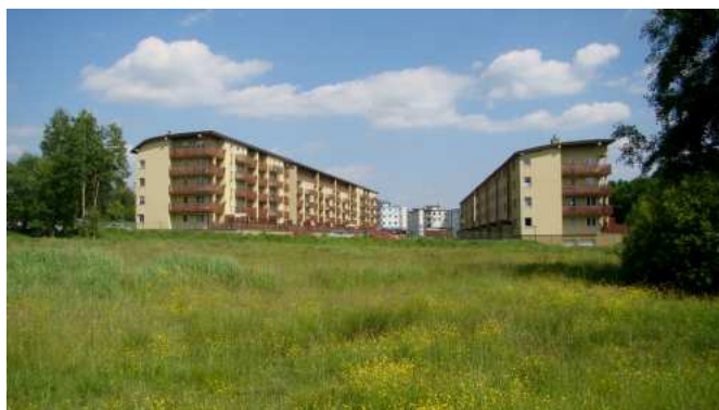
Widok na to samo osiedle – czerwiec 2011 rok.
