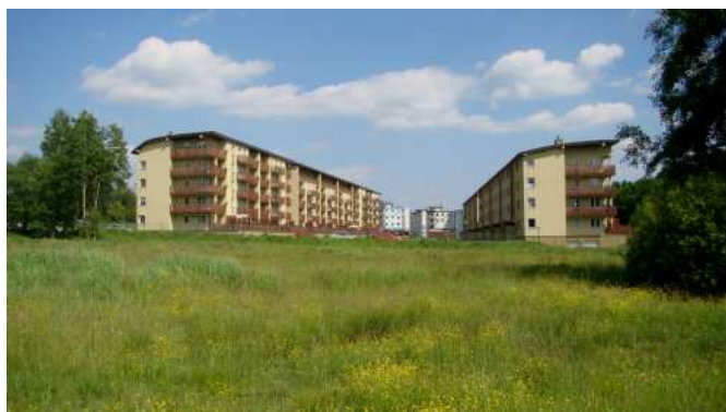
Widok na to samo osiedle – czerwiec 2011 rok.
