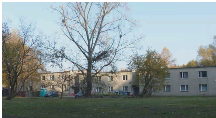
Teren istniejącej zabudowy wielorodzinnej w obszarze planu
